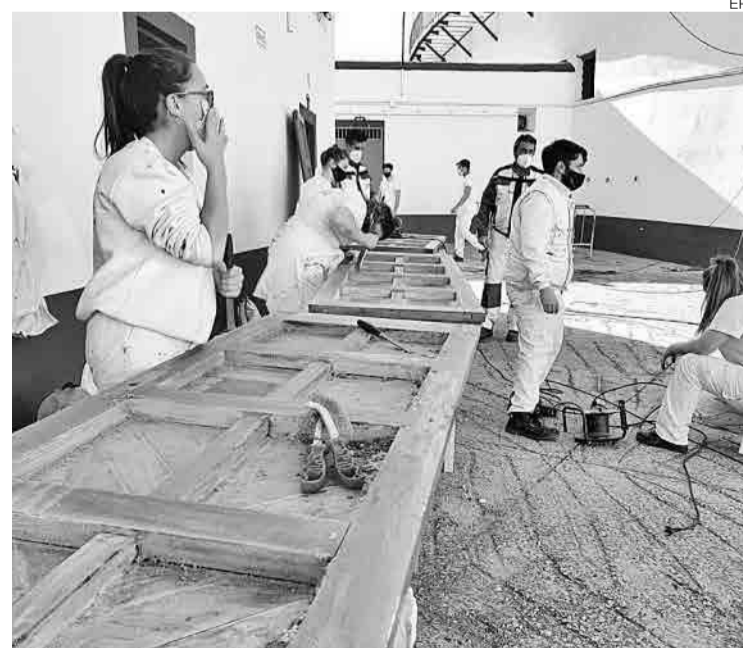
► Trabajos de adecentamiento de las puertas de la plaza de toros.
