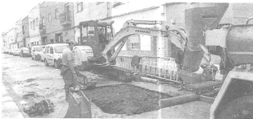
Las obras están centradas en la red de saneamiento de la calle. CASIMIRO MORENO
