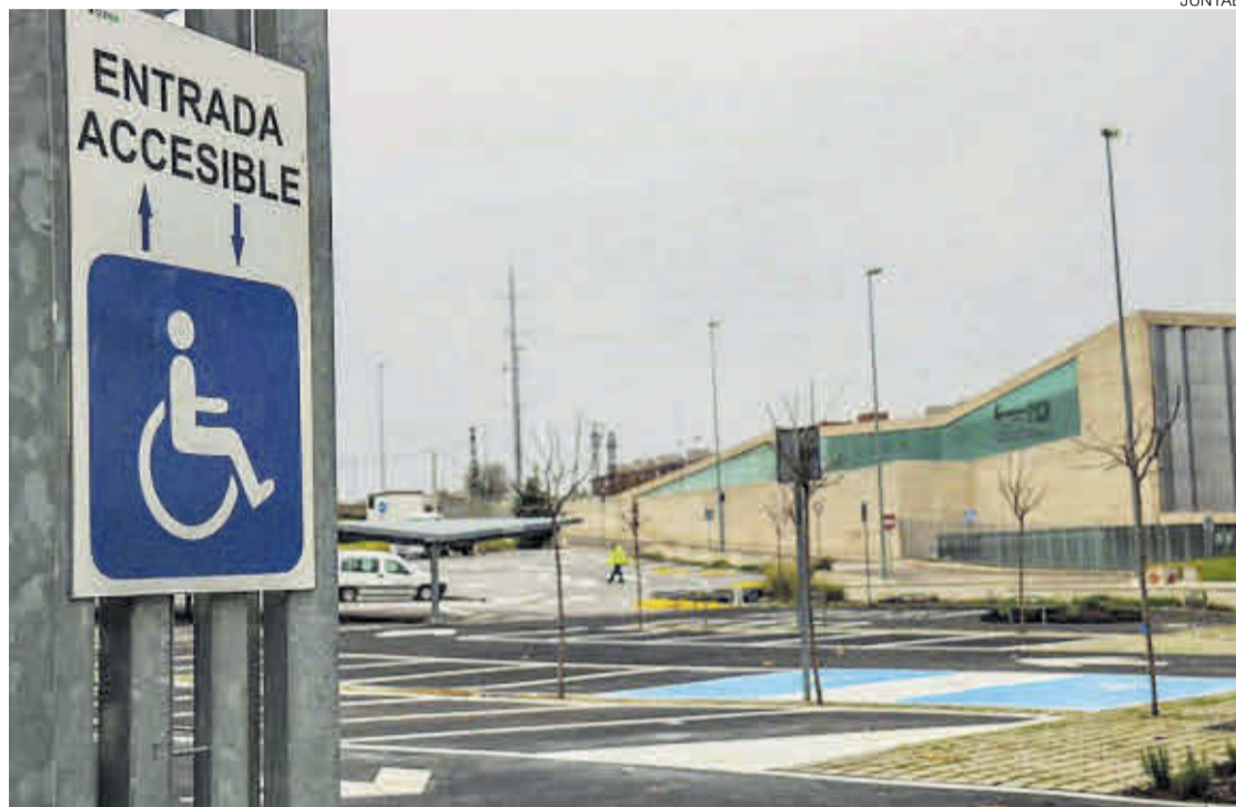
► Estado que presenta el aparcamiento del Tercer Milenio tras las obras de mejora.
