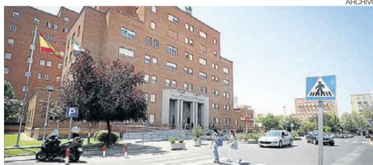
▶ Fachada del Hospital Perpetuo Socorro de Badajoz.
